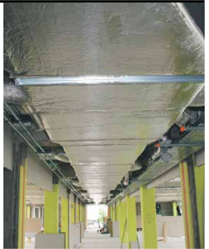
De ventilatie volgt de middengang met zijkanalen naar de lesruimten.
