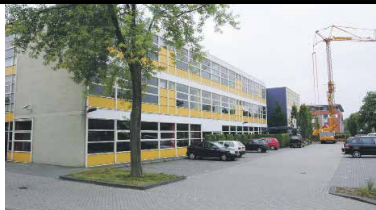
Het schoolgebouw uit 1980 is gestript tot op het betonskelet.
