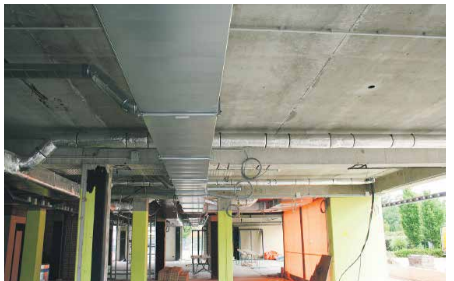
De ventilatie volgt de middengang met zijkanalen naar de lesruimten.
